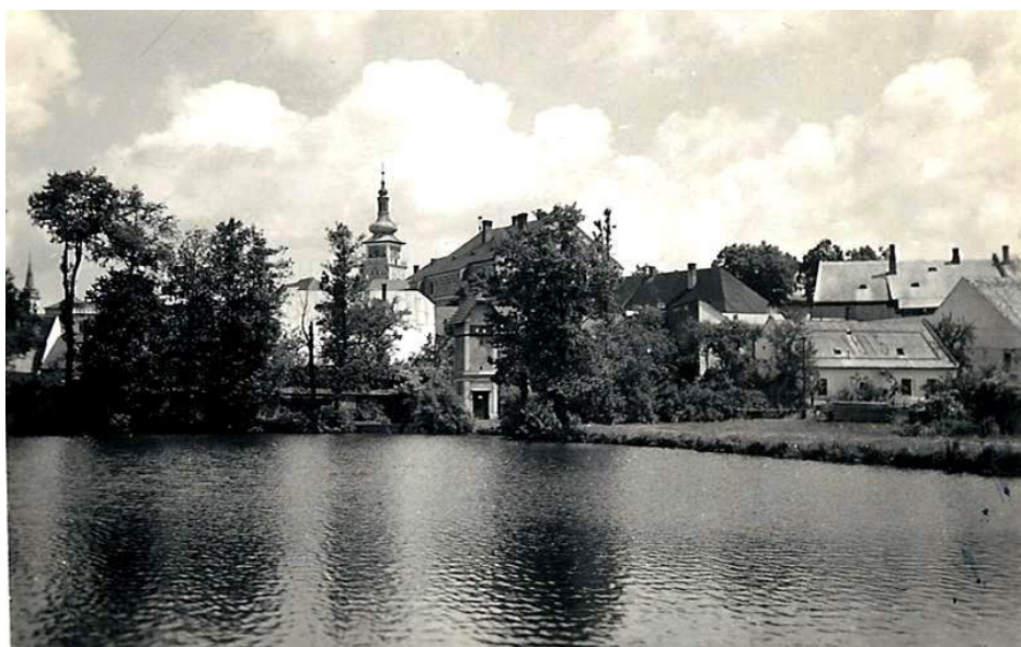
Pohled na Kazmírák s trafostanicí
