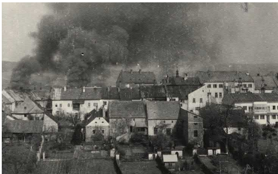
Požáry na Žďárské ulici při pohledu od Horního dvora
