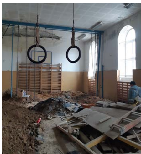
Sanace základů pod tělocvičnou
