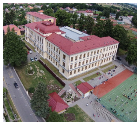
Pohled na budovu školy z roku 2017 (zdroj archiv školy)
