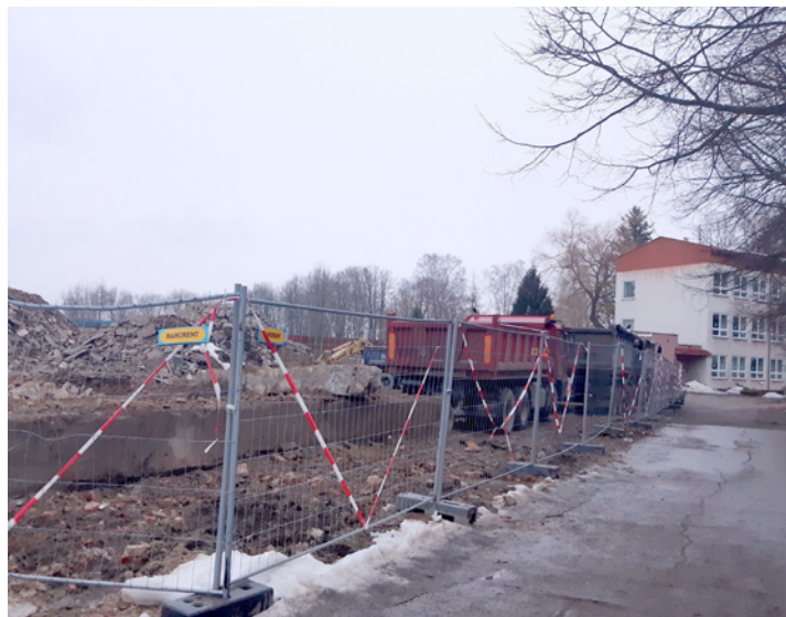
Místo, kde stála budova bývalého střediska. Příští rok touto dobou zde bude stát nová Sportovní hala.
