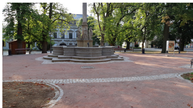
Jedna z investic města - už opravený povrch na Vratislavově náměstí.
