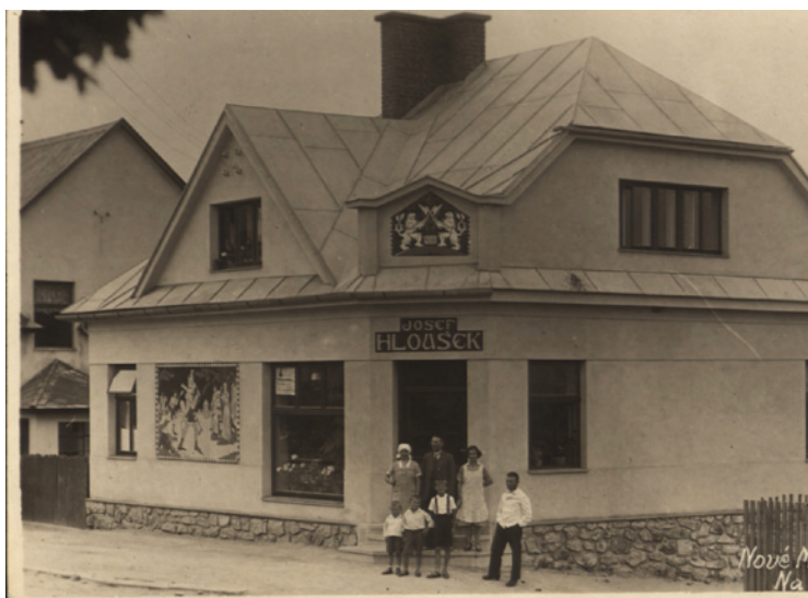
Dům řezníka Hlouška na Štursově ulici 438 s dnes již částečně zmizelými sgrafity
