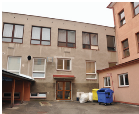
Nové patro vznikne nad jídelnou, rekonstrukce se dočká i dvůr.
