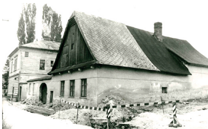
Kopáčekův dům čp. 154 před zbořením, v pozadí dodnes stojící dům čp. 153
