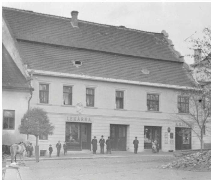
Lékárna v domě čp. 119
