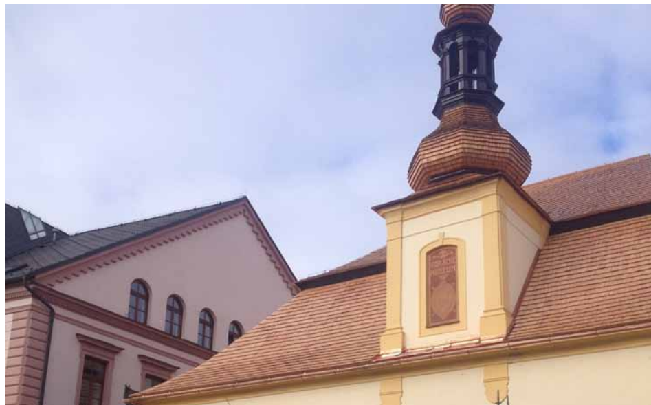
Horácké muzeum se pyšní novou šindelovou střechou. Rekonstrukce trvala téměř půl roku a obnášela vystěhování depozitáře, opravu půdních prostor a výměnu šindelů.
