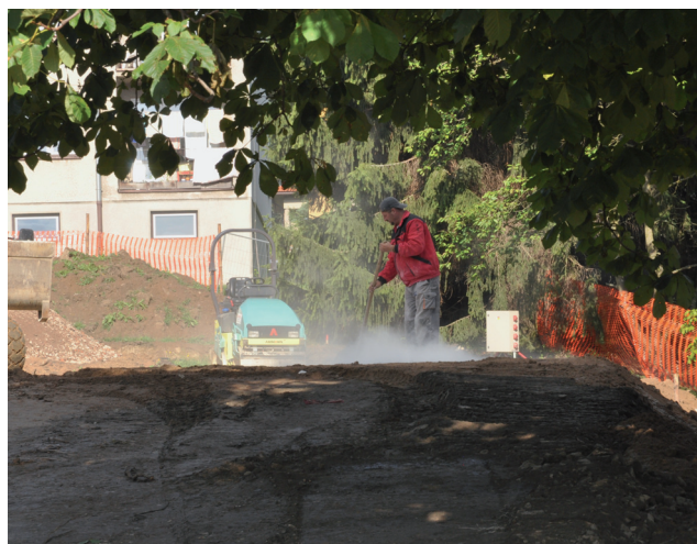
Dělníci sypou vápno na povrch stavby.
