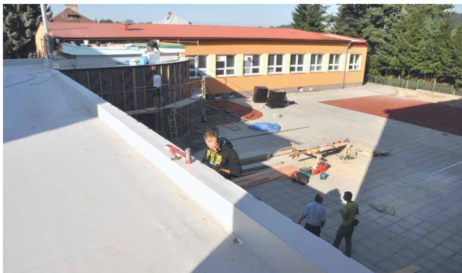
Stavba spojovacího krčku v ZŠ Leandra Čecha
