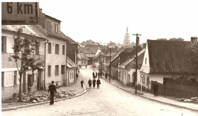
Pohled do Žďárské ulice v roce 1943 směrem od nemocnice. První zleva dům čp. 71. V zatáčce v pozadí dosud stojí dům Vyplašilových čp. 82, zničený při bombardování v květnu 1945. Většina domů po pravé straně byla zbořena a na jejich místě byl postaven Dům s pečovatelskou službou.
