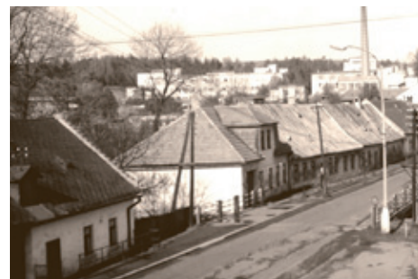
Pohled na zmizelou část Žďárské ulice. Před mostem dnes ještě stojí dům čp. 54, ale domy za mostem (čp. 55-60) již nahradil Dům s pečovatelskou službou.
