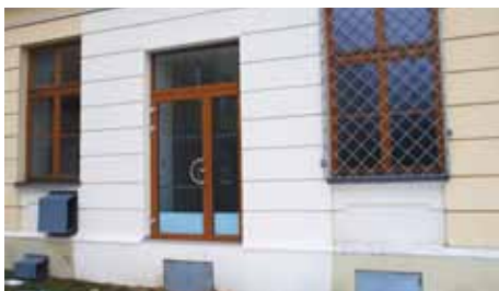
Těmito nově vybudovanými dveřmi se bude vstupovat z gymnázia do spojovacího krčku.
