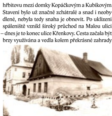
Kopáčkův dům čp. 154 před zbořením. V pozadí dodnes stojící dům čp.153
