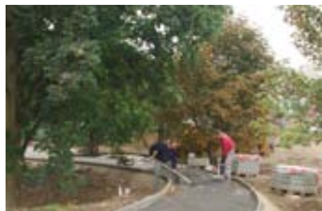
Zároveň s dokončováním stavby probíhají úpravy okolí.
