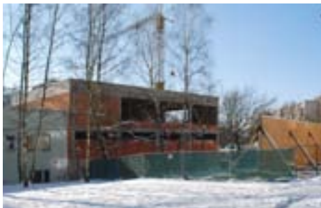
V únoru 2015 už stála hrubá stavba lázní.
