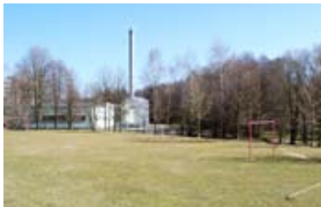
Na jaře 2014 vypadalo místo budoucí stavby takto. Vidět můžete ještě i bývalý sklad uhlí (zelená budova).
