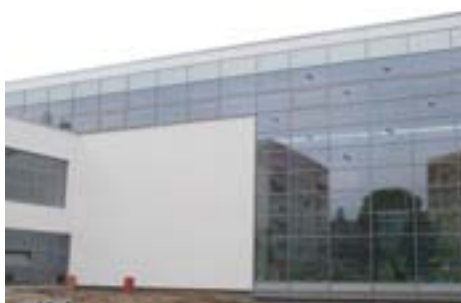
Vstupní budova v září 2015.
