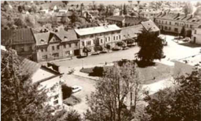
Pohled na Komenského náměstí a Škrlův dům „vylepšený“ nástavbou.
