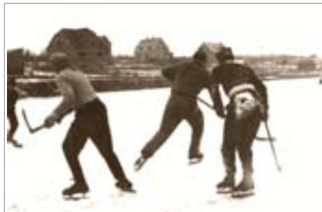
Hokejisté na Klečkovci a novostavby na Veslařské ulici.
