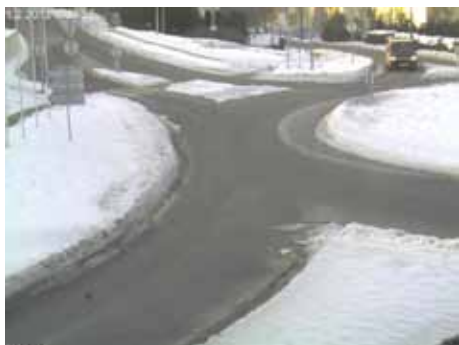
kruhová křižovatka na ulici Brněnská
