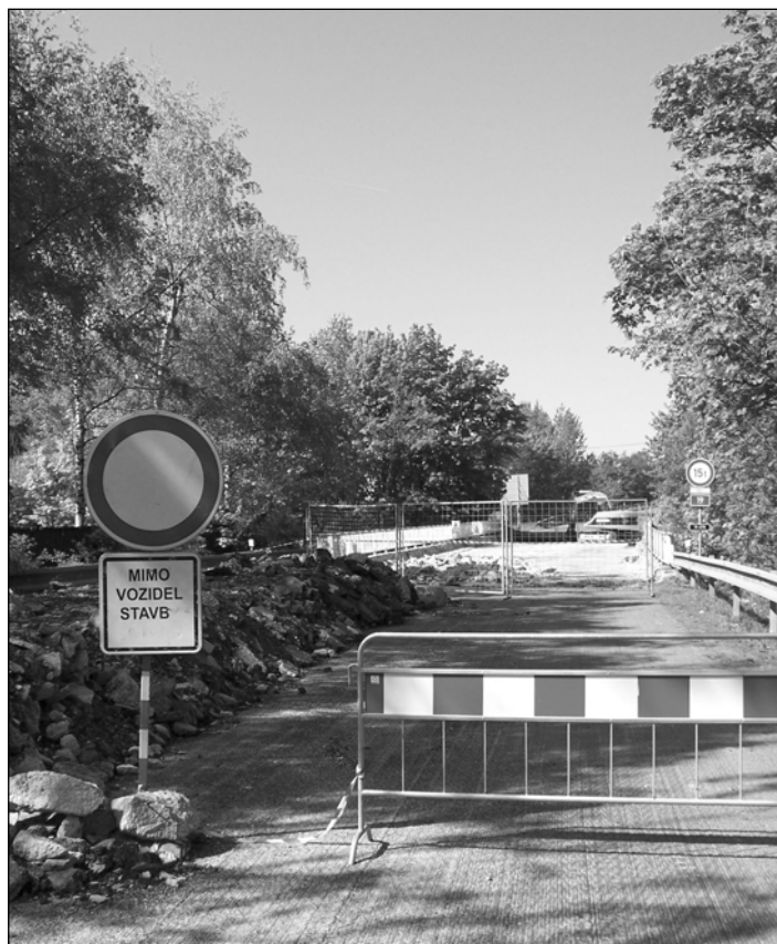
Práce na opravě mostu přes Bezděčku na silnici I/19 u kruhového objezdu začaly. A na zvýšené dopravě na Žďárské ulici je to znát...
