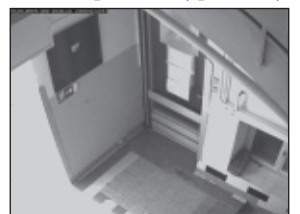
KAMEROVÝ BOD Č. 7 Vratislavovo náměstí č.p. 12 zadní vstup do budovy polikliniky
