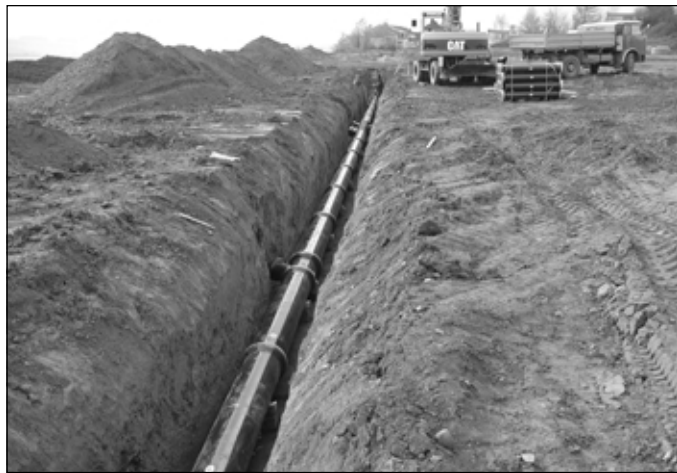
Kanalizační potrubí se pokládalo v dubnu.
