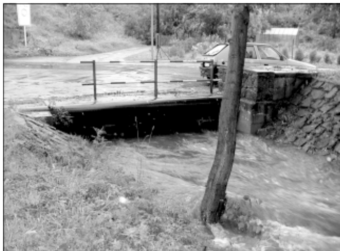
Na snímku nahoře je vidět, že u viaduktu, na křižovatce ulic Veslařská, Bělsko a dalších, šla 13. 8. voda pod mostem i nad mostem. Snímek uprostřed - hráz nad koupalištěm o týden později. Na spodním snímku část humanitární pomoci snromážděná v DPS.
